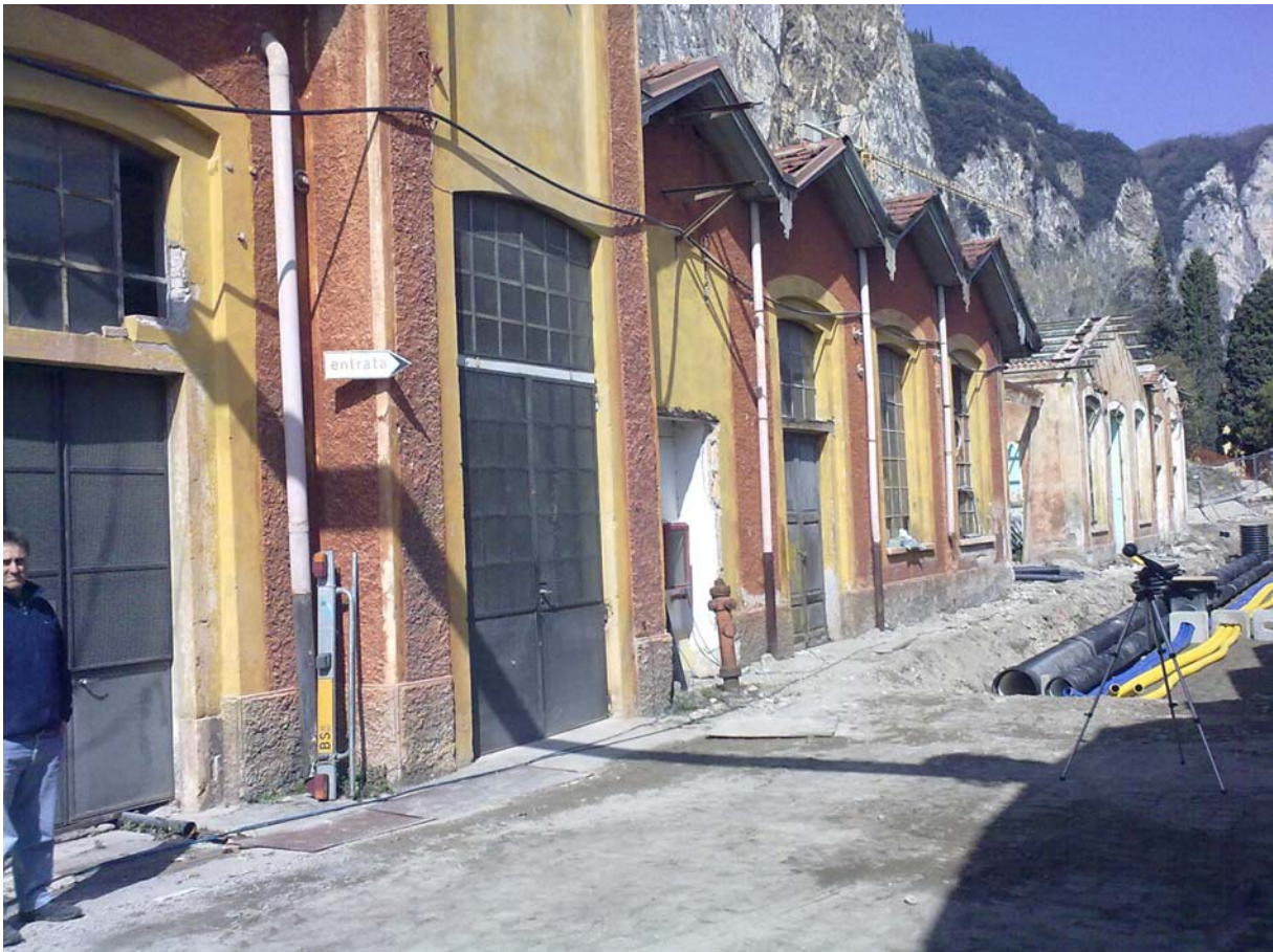
Fig. 28 – Portone in acciaio e vetro di accesso alla centrale idroelettrica.
