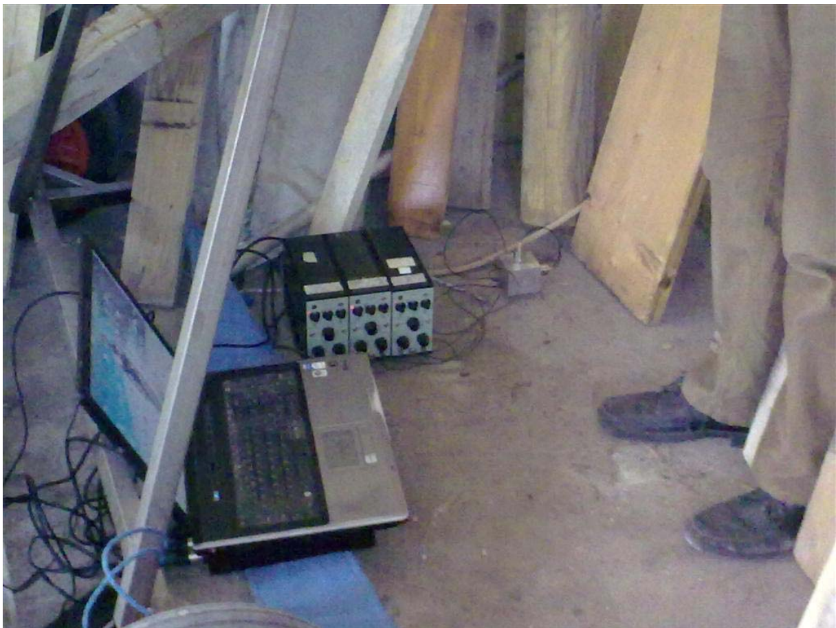
Fig. 22 – Punto Misura Vibrazioni 3.
