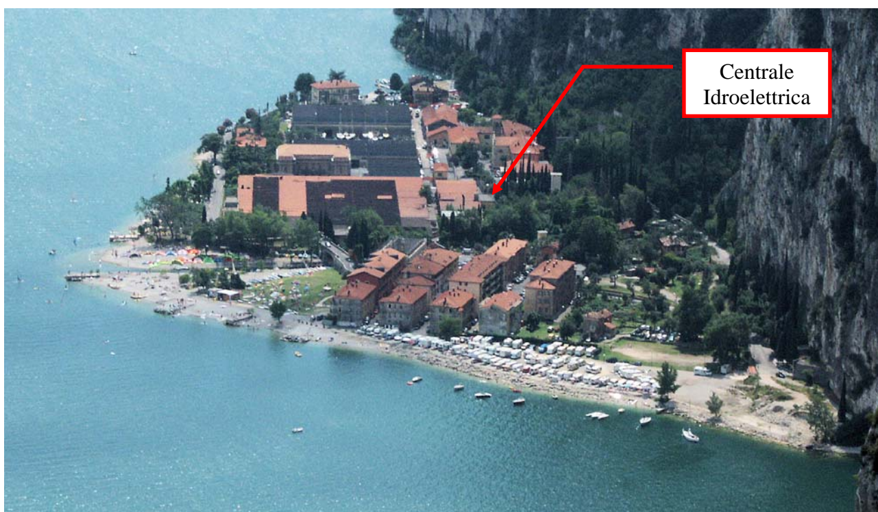
Fig. 1 – Foto a volo d'uccello del territorio circostante la Centrale Idroelettrica di Campione del Garda.
