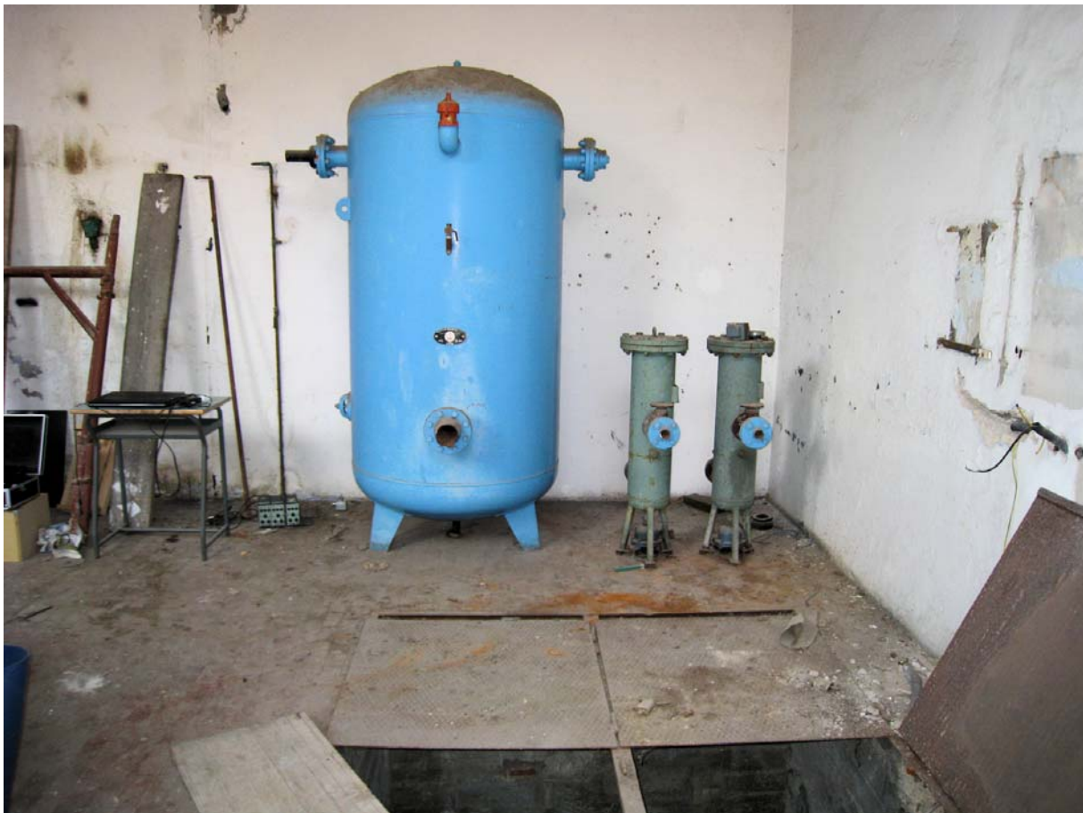
Fig. 17 – Punto Misura Vibrazioni 2.
